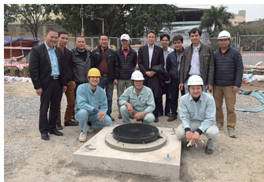
写真-2 マンホール蓋モデル施工（ハノイ2016年：日本大使館前）
