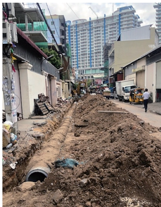
写真-3 プノンペンにおける管きょ整備工事
