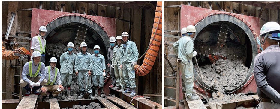
写真-1 ハノイ市エンサ下水道整備事業・パッケージ2管路施工状況（2022年10月、筆者撮影）
