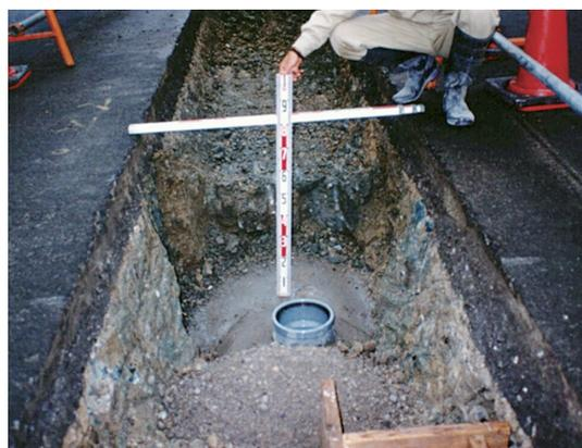
写真-1 土被り0.8m（取付管施工時実測）
