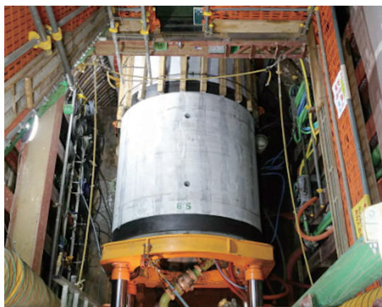
写真-1 大口径長距離現場
