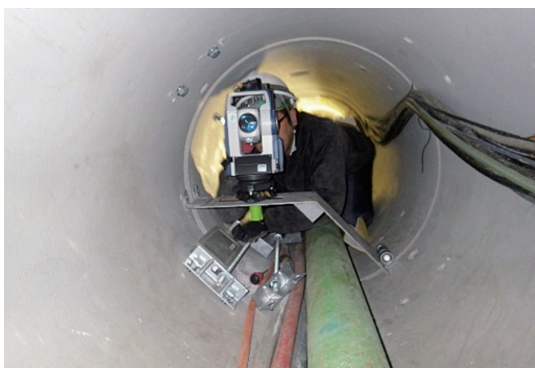
写真-1 管内測量状況（呼び径800）
