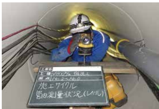
写真-2 呼び径800管内測量
