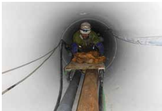
写真-1 呼び径1000管内移動
