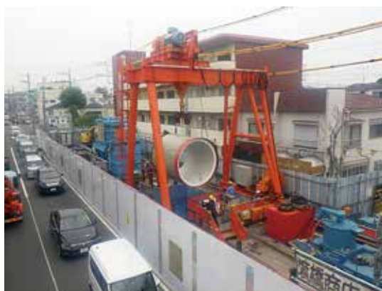
写真-1 本市発注工事における施工状況例
