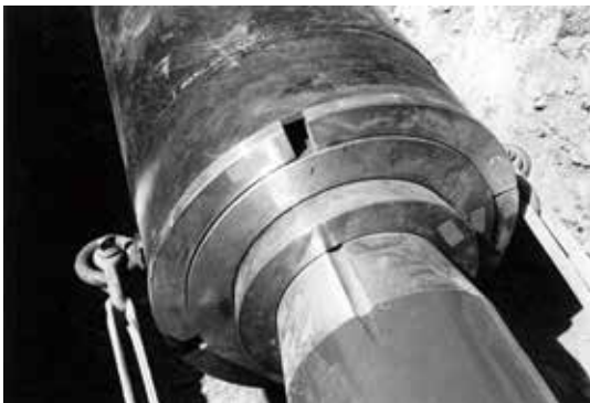
写真-5 マスターコーン取付状況
