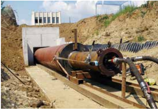
写真-3 インパクトモール施工状況
