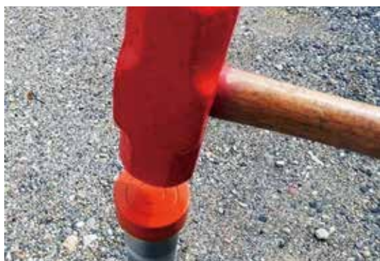
写真-1 単管パイプをハンマで打ち込む様子
