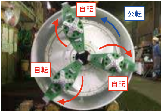
写真-1 オーバカッタ（自転公転：掘進中）
