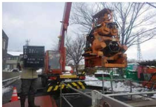
写真-1 推進設備荷下し
