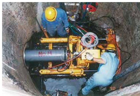
写真-4 303型のφ2,000mmケーシング立坑から発進状況
