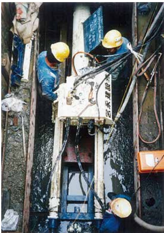
写真-1 エンパイナ工法第1号機試験施工状況
