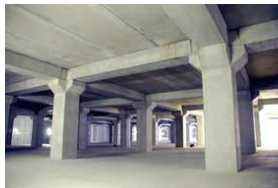
写真-3 大州雨水貯留池（球場のグラウンド地下）
