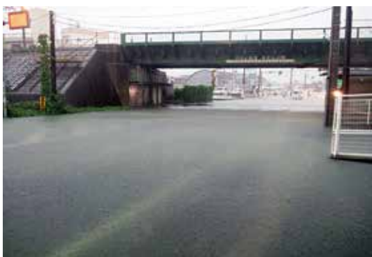
写真-2 道路冠水の状況（2013年）
