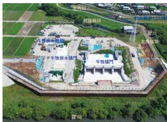
写真-3 犀川遊水地事業での河川整備（2021年）
