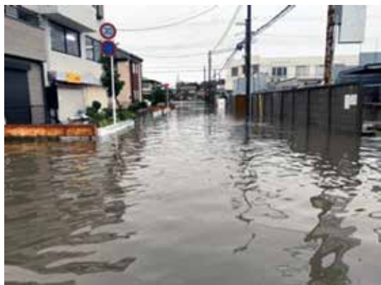
写真-2 住宅地の浸水状況 (R1.10.25)
