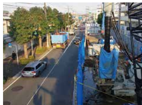
▲ 発進立坑鋼矢板打設 (2021年11月)
