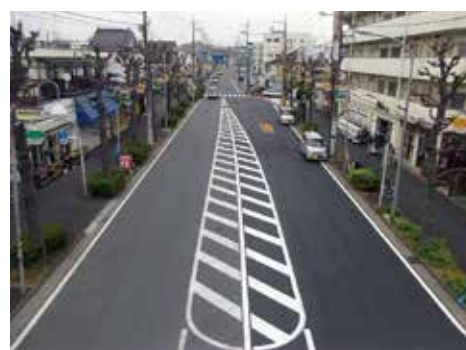
▲ 発進立坑用地 (2020年3月)
