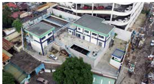
写真-1 タラヤン下水処理場（完成後）
