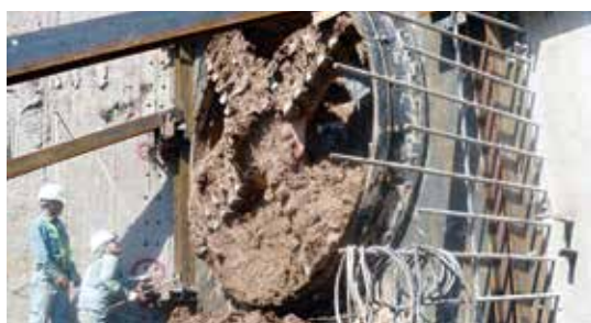
写真-3 遮集管工事（処理場に到達）
