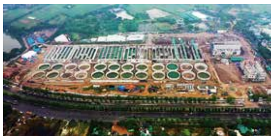
写真-2 エンサ下水処理場 2021年10月
