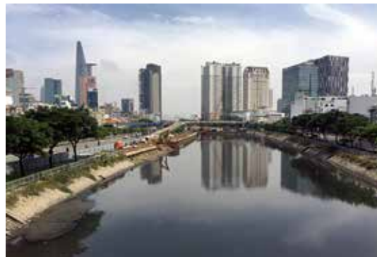
写真-2 進むホーチミンの近代化（道路拡幅工事）
