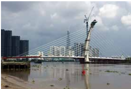
写真-1 進むホーチミンの近代化（橋梁工事）
