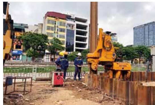
写真-2 鋼矢板打設状況
