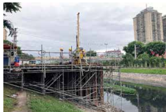
写真-3 JSG施工状況
