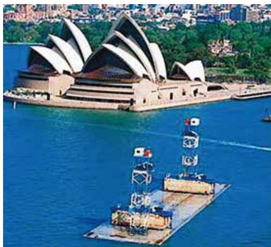
写真-2 豪州 シドニーハーバートンネル (BOT)
