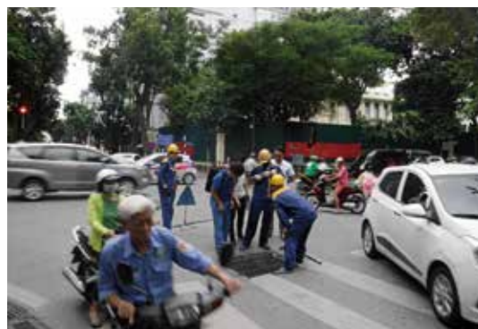
写真-4 ハノイ市における下水道管きよの調査
