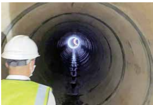
写真-2 排水管内（内径2,300mm、刃口式推進工法）
