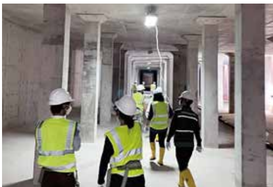
写真-1 地下貯留槽内 公共事業・運輸省現場視察時
