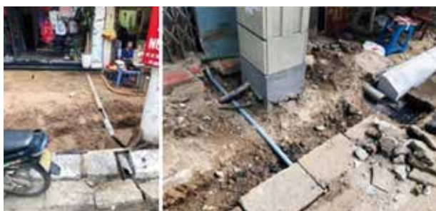
写真-1 ハノイ市中心市街地での一般的な家屋接続
