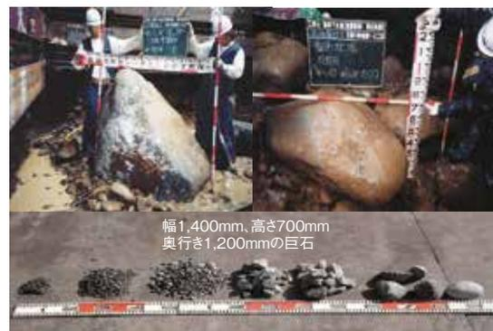
写真-4 巨石の出土と掘進機による破碎状況
