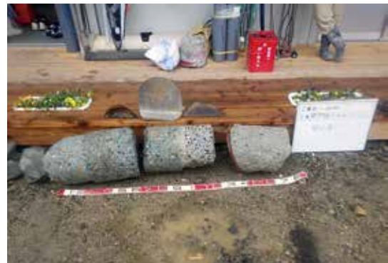
写真-2 抜き取られたコンクリート
