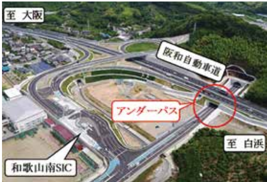
写真-1 工事全景
