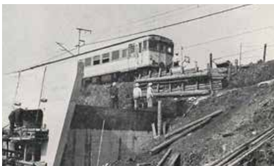
写真-1 信越線横断工事
