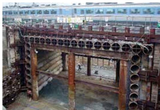
写真-3 鋼管による軌道防護 2) (パイプルーフ工法)
