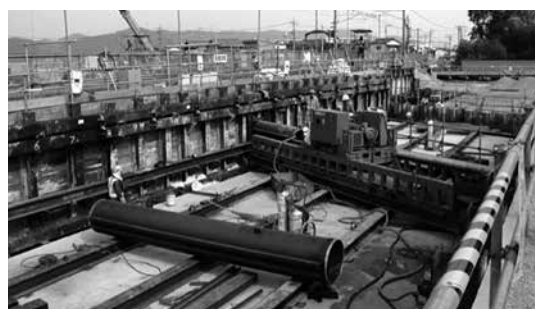
写真-2 線路直下における鋼管推進 1)
