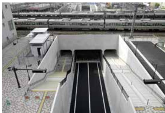
写真-1 線路下横断函体 1)
