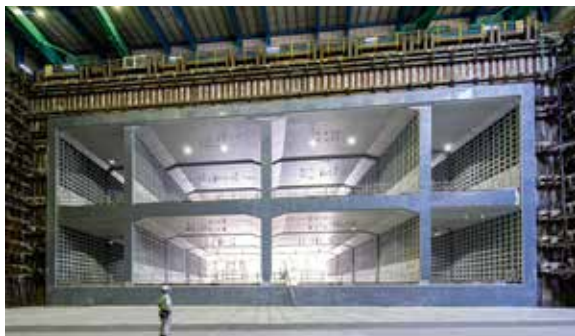
写真-4 R&C工法で築造された道路の大断面函体 3)
