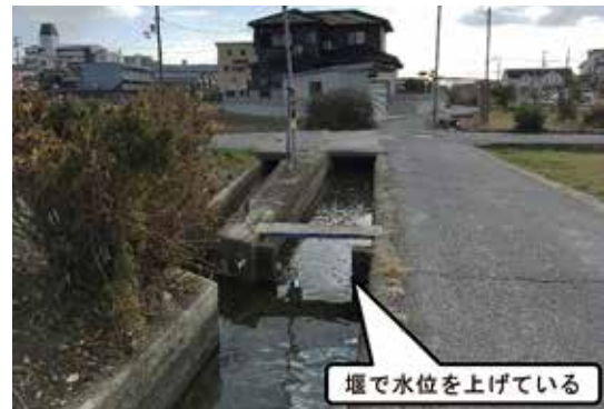
写真-2 既設水路状況写真
