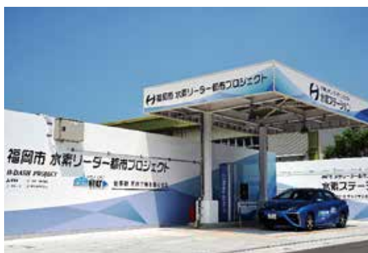
写真-1 下水バイオガス水素ステーション
