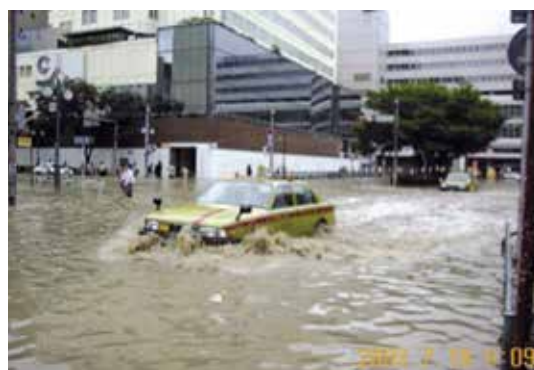
写真-2 博多駅周辺の浸水被害状況（H15.7.19）
