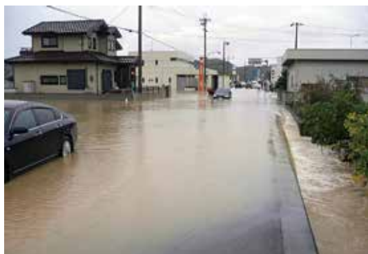
写真-1 浸水状況
