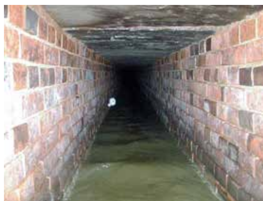
写真-1 明治期に築造した矩形煉瓦下水道（第一期工事）
