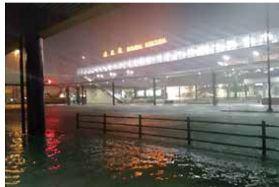
写真－3 仙台駅西口の浸水被害状況（令和元年10月12日 台風19号）
