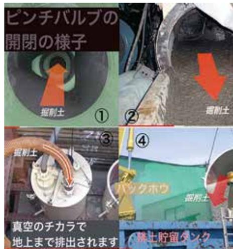
写真-1 掘削した土砂のゆくえ (サンシールド株式会社内教育資料より)
