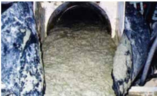
写真-2 掘進機内での排土状況（砂礫層）
