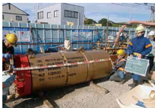
写真-2 分解回収型掘進機
