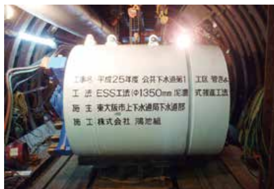
写真-1 掘進機シールド坑内据付状況
