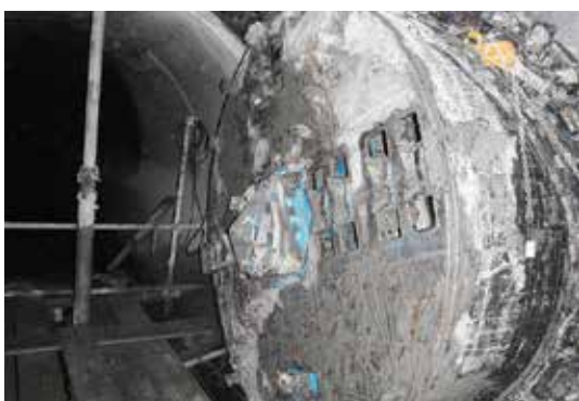
写真-2 既設構造物到達
