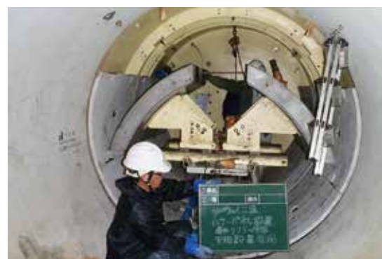
写真-4 インナーパネル設置
