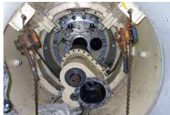
写真-3 内部機器解体
