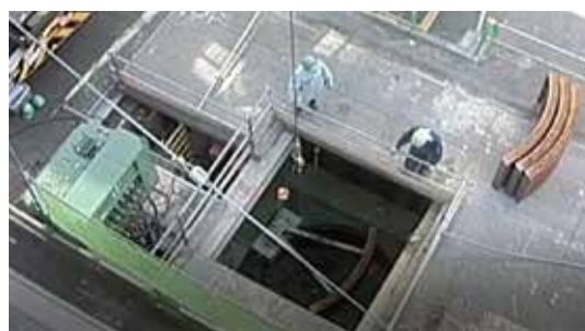
写真-1 アーバンリング施工状況
