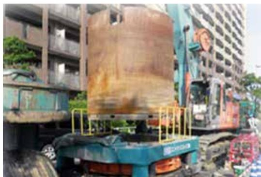
写真-1 ケーシング立坑施工状況<sup>1)</sup>
