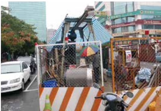
写真-2 台湾台中での推進工事施工状況
