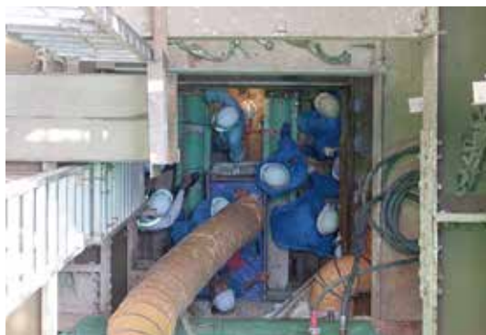
写真-1 ベトナムの推進工法の現場
