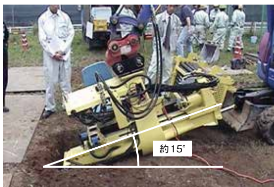
写真-1 フレックスドリル工法
