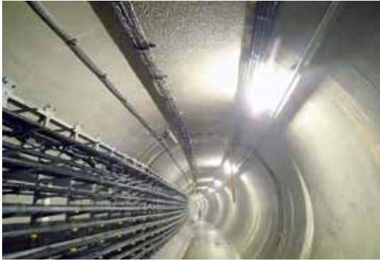
写真-1 シールドとう道の内部
