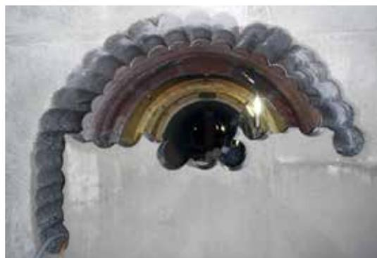
写真-1 コア削孔による鏡切り（大師河原貯留管内部より見た状況）
