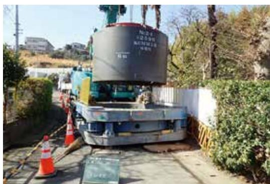
写真-2 狭隘道路における発進立坑築造
