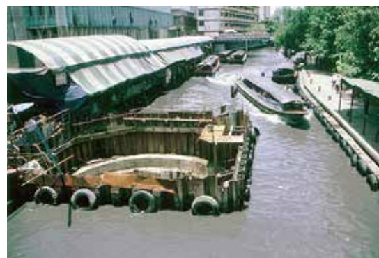
写真-3 バンコクの運河内の発進立坑
