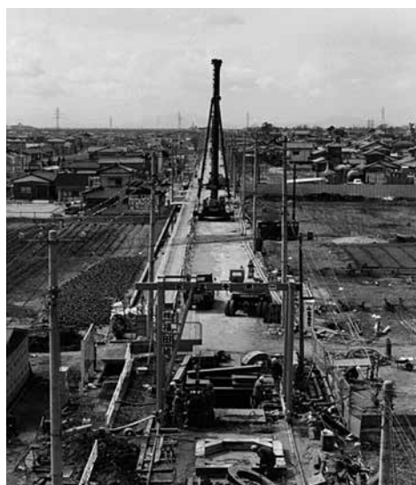
写真-1 初めての推進工事現場
