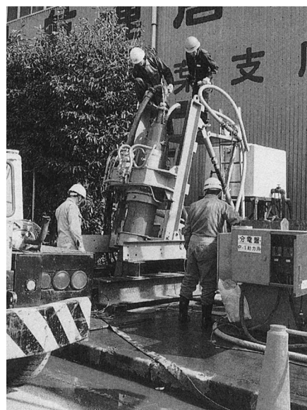
▲ YHC工法施工状況
