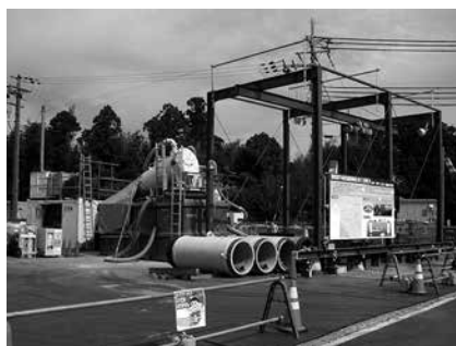
写真-1 作業ヤード
