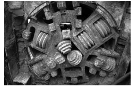
写真-3 鋼矢板Ⅲ型、切削貫通
