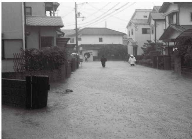
写真-1 浸水被害箇所①
